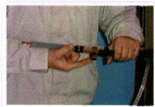
1. 電纜準備完成施作 接地銅環組
