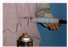
3. 反時針方向拉掉 內支撐塑膠帶
